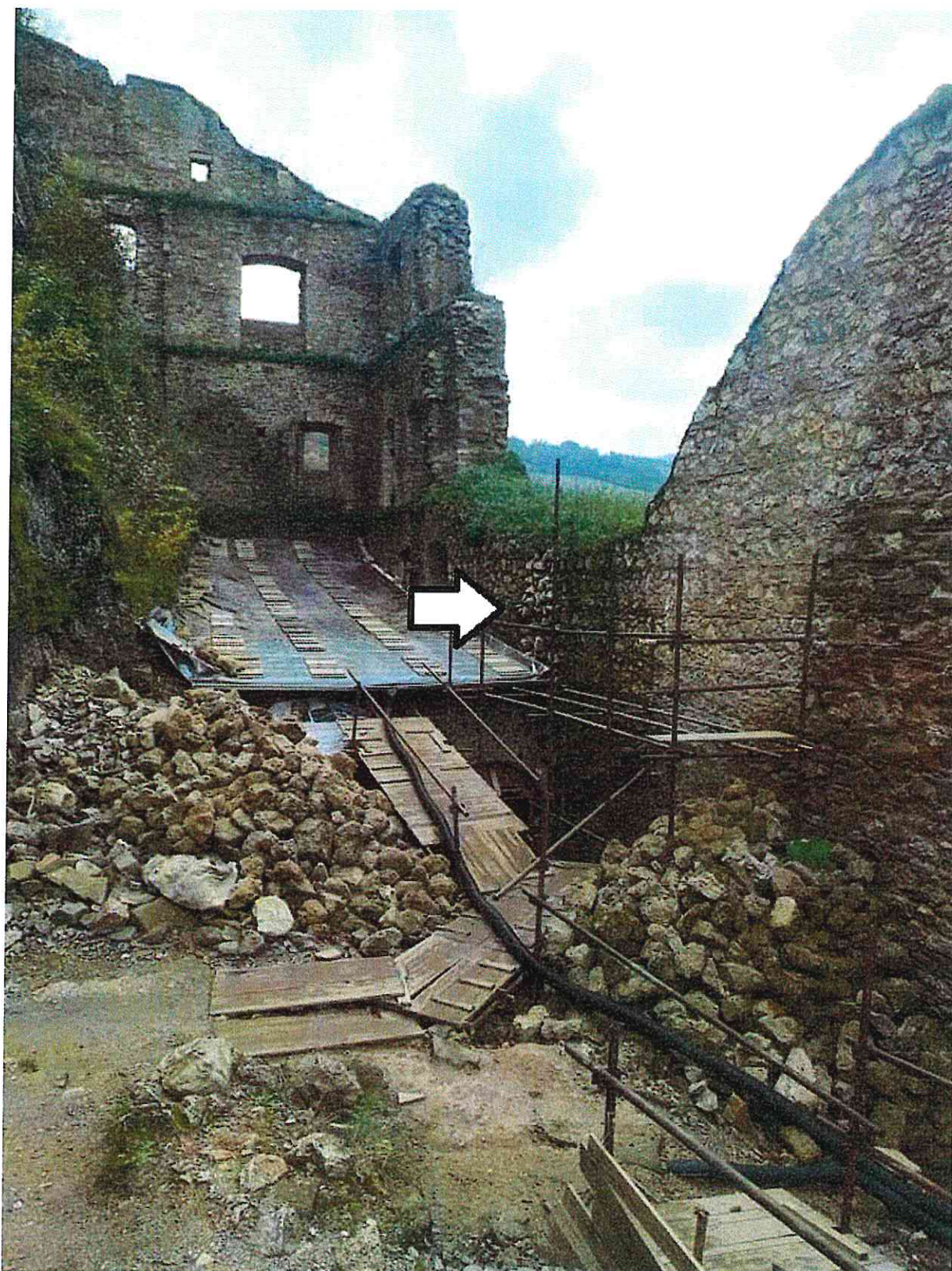
Šípka označuje miesto priečky nad vstupom do pivnice, pre zaizolovanie klenby je nutné ju čiastočne obnoviť.
