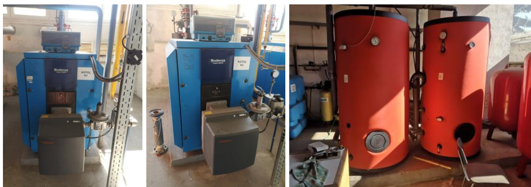
Obr. 9. Tepelné zdroje a vybavenie kotolne – umiestnená v SOŠ
