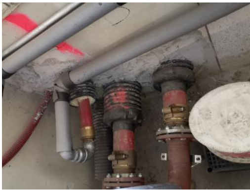
Obr. 11. Rozdeľovač a zberač v objekte
