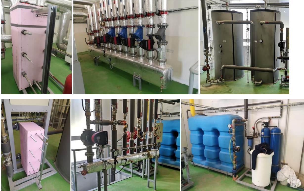
Obr. 10. Vonkajšie rozvody na vstupe do objektu
