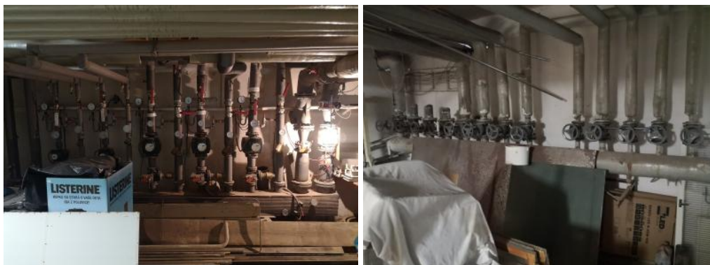
Obr. 11. Rozdeľovač a zberač v objekte
