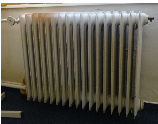
Obr. 9 Vykurovacie teleso – oceľové rebrované vykurovacie teleso
