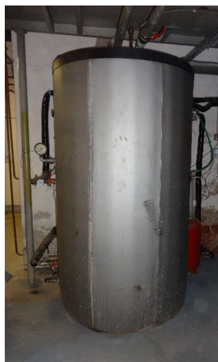
Obr. 10 Vľavo akumulčný zásobník teplej vody, vpravo solárny zásobník predhrievanej vody
