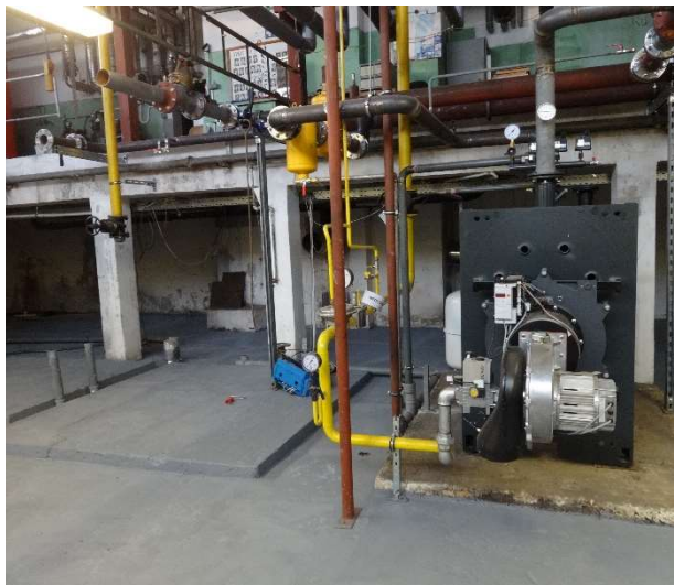
Obr. 5 Stacionárny kondenzačný plynový kotol Viessmann Vitocrossal 30 CRU
