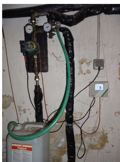
Obr. 11 Vpravo dve polia solárnych panelov, vpravo čerpadlová skupina solárneho systému.
