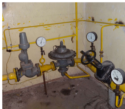
Obr. 4 Regulačná stanica plynu – fakturačný plynomer, regulátor tlaku plynu
