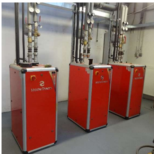
Obr. 6 Vnútorná a vonkajšia jednotka tepelného čerpadlá typu vzduch-voda MasterTherm EM75Z
