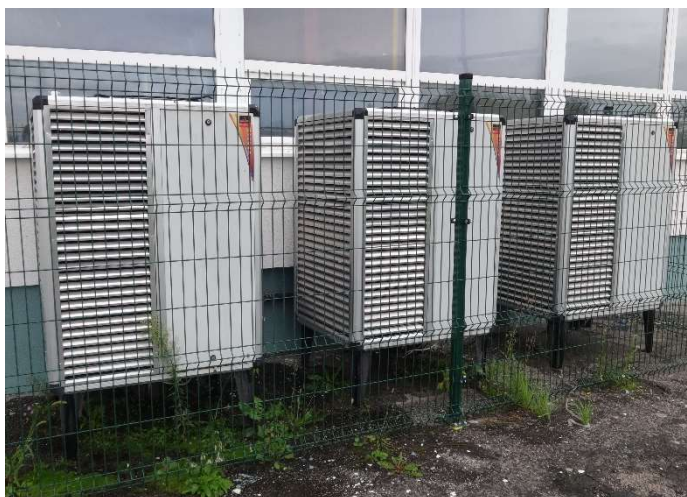
Obr. 6 Vnútorná a vonkajšia jednotka tepelného čerpadlá typu vzduch-voda MasterTherm EM75Z
