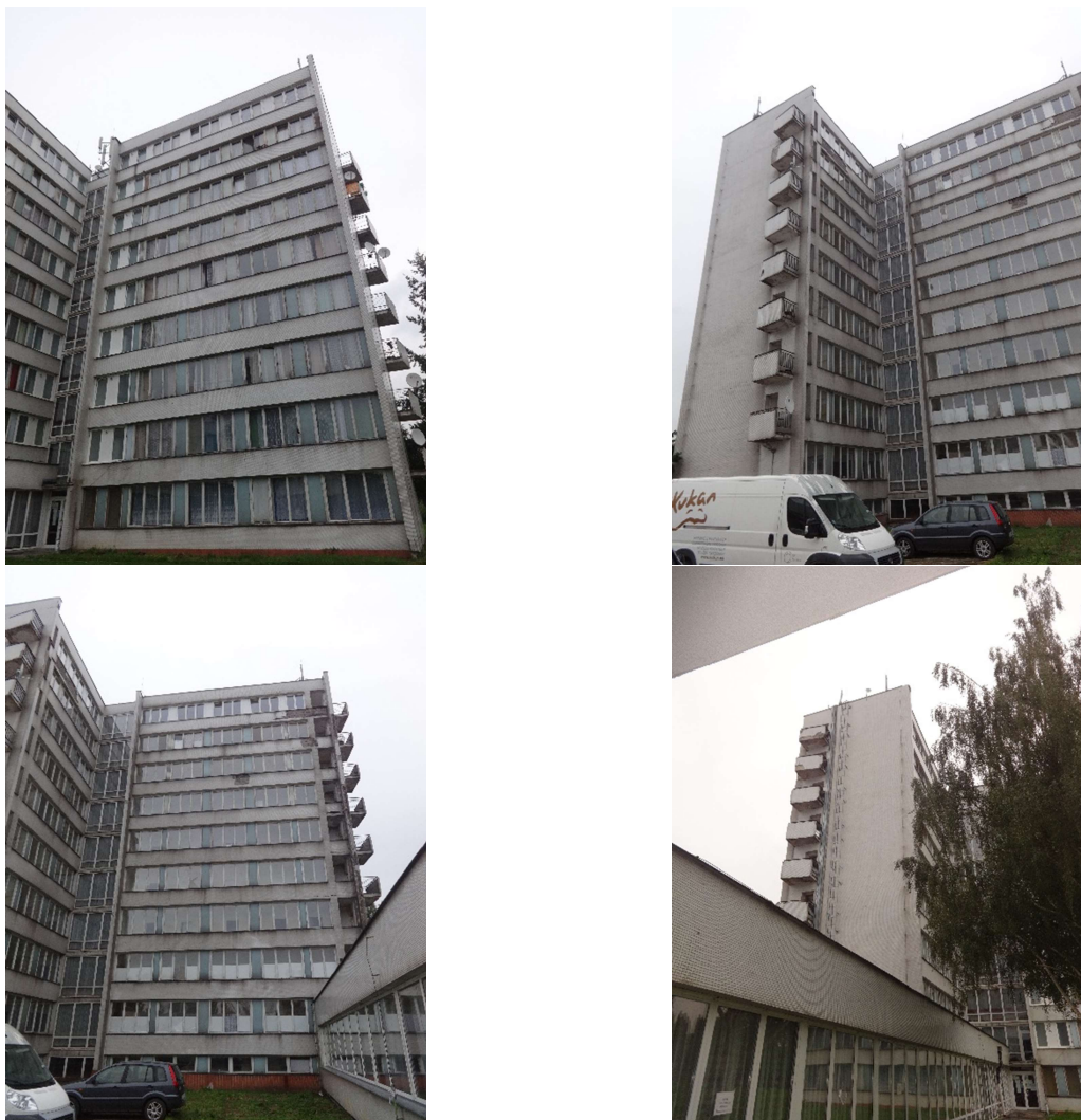
Obr. 3 Pohľady na budovu
