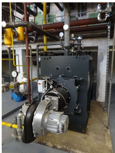
Obr. 5 Stacionárny kondenzačný plynový kotol Viessmann Vitocrossal 30 CRU
