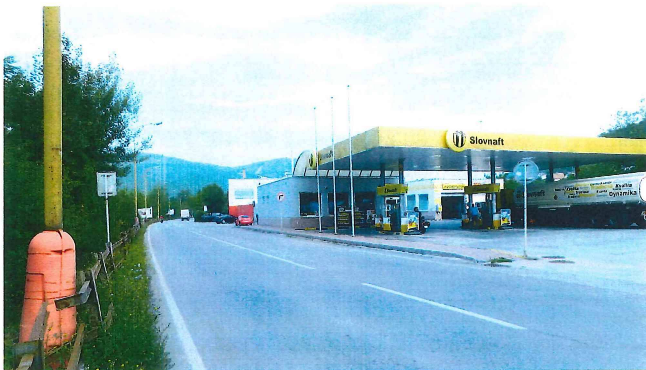
Štátna cesta č. II/507 – obchvat miestnej časti Orlové, južná časť novoutvorenej KN-C parc. č. 1248/32 – pohľad od juhu
