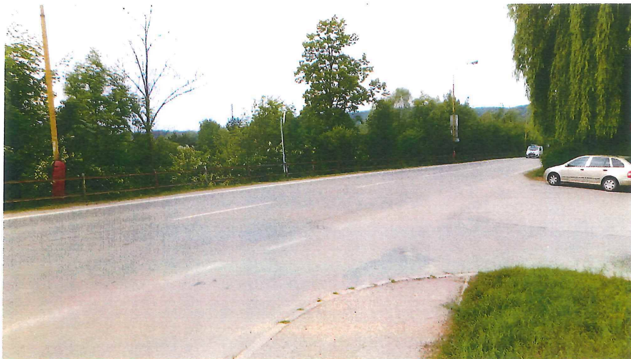
Štátna cesta č. II/507 – napojenie na sieť miestnych komunikácií miestnej časti Orlové, novoutvorená KN-C parc. č. 1248/29 pred miestnym cintorínom – pohľad od východu
