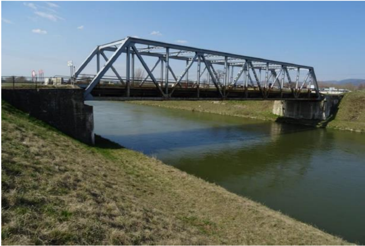
Foto: Mostný objekt 574-003 cez Vážsky kanál v Ilave
