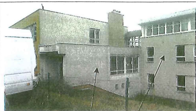
Spojovacia chodba do časti B a časť B
