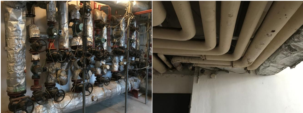
Obr. č. 5, 6. Rozvody tepla z tepelnou izoláciou.
