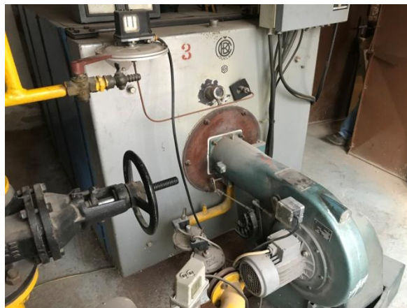
Obr. č. 4. Kotel č. 3 s plynovým horákom
