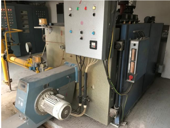
Obr. č. 2. Kotel č. 1 s plynovým horákom
