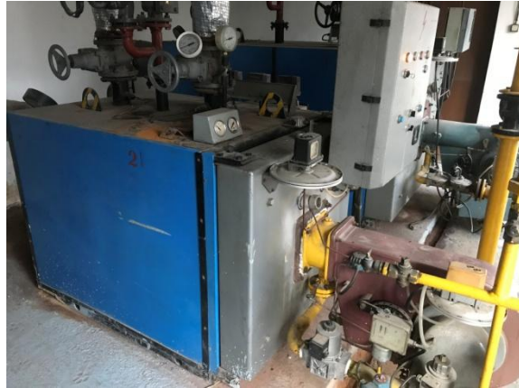
Obr. č. 3. Kotel č. 2 s plynovým horákom
