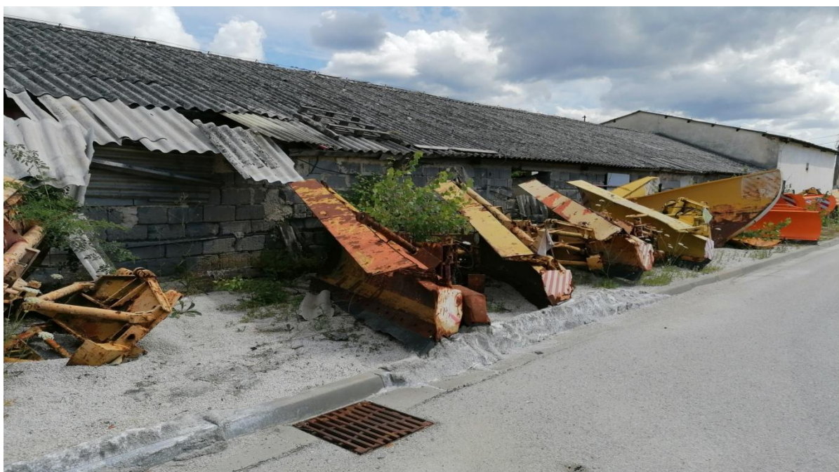
Pohľad zadný na strechu prístrešku
