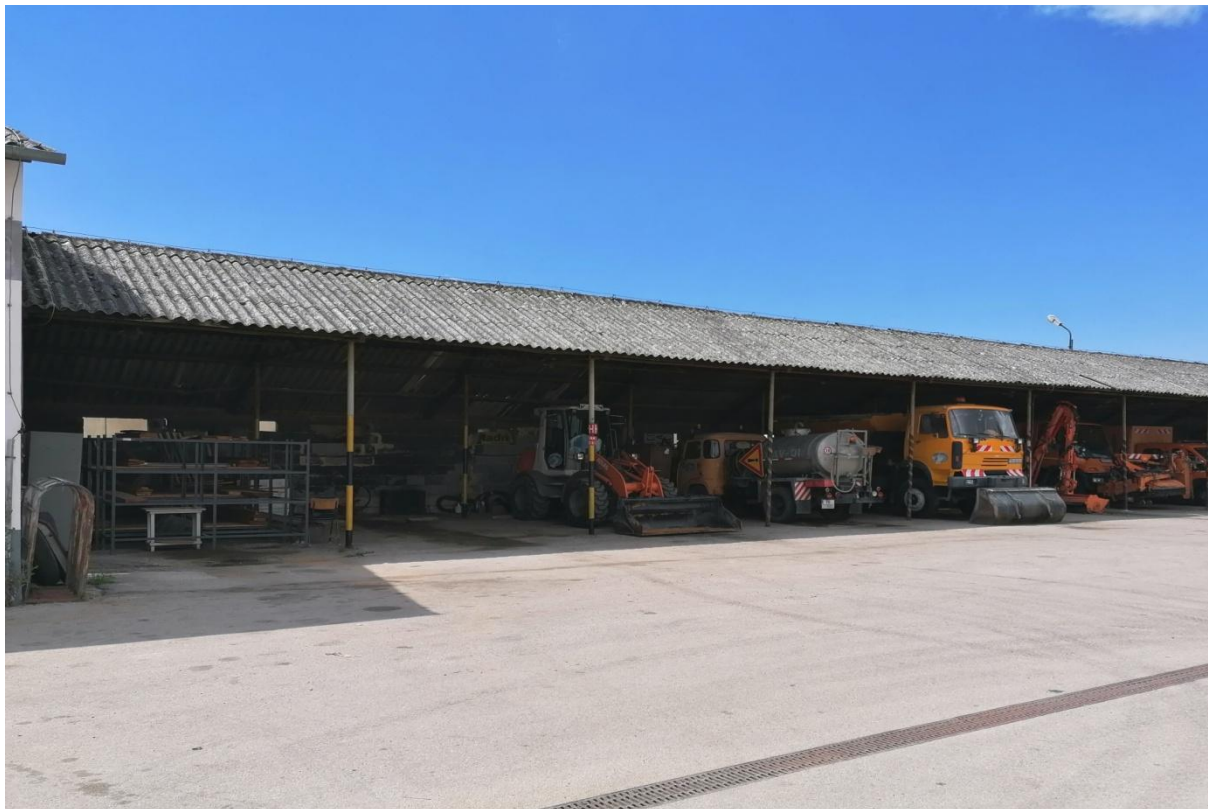
Pohľad čelný /azbestocementová krytina, čelné stĺpy/
