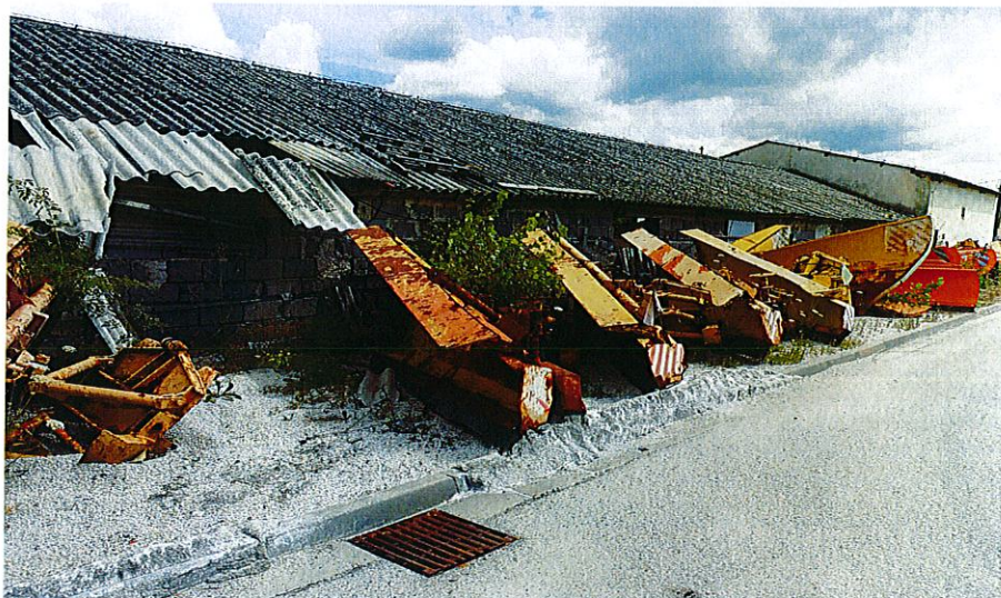
Obr.č.3 Pohľad zadný, pohľad na strechu prístrešku
