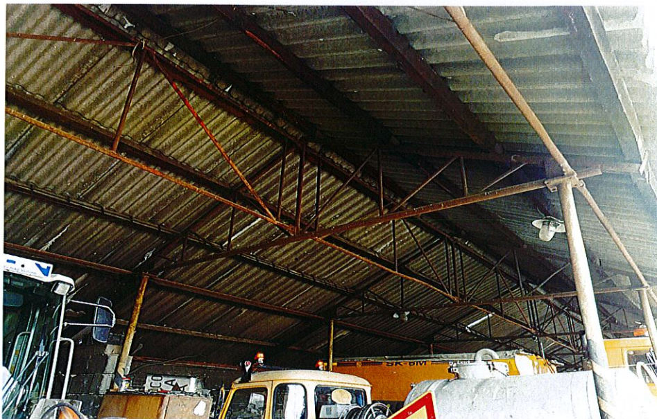
Obr. č.1 Pohľad konštrukciu strechy /azbestocementová krytina, drevené väznice/
