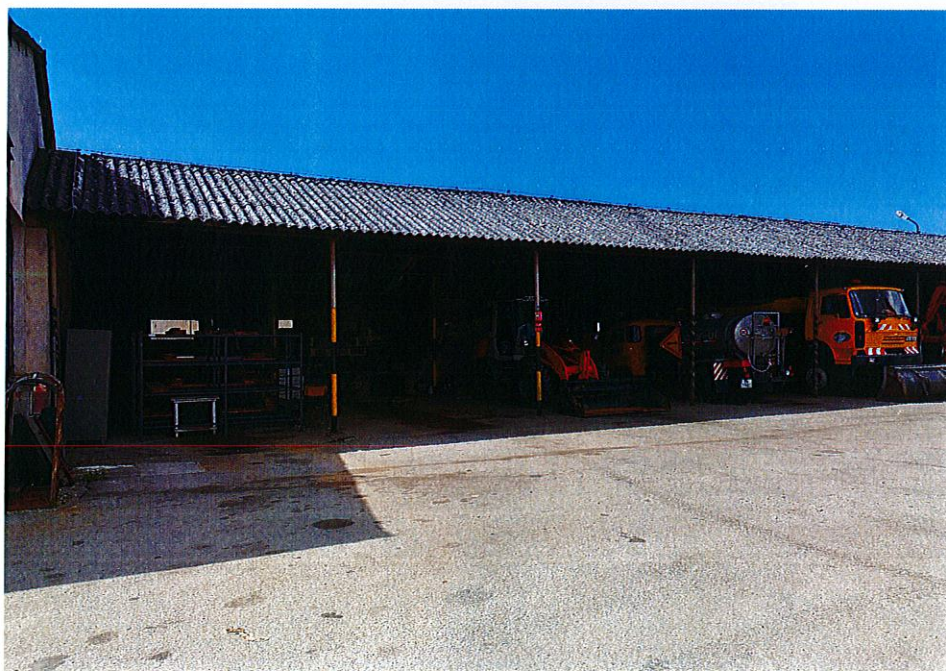
Obr. č.2 Pohľad čelný /azbestocementová krytina, čelné stĺpy/
