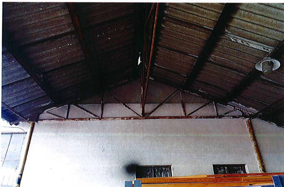
Obr.č.4 Pohľad na strešnú konštrukciu
