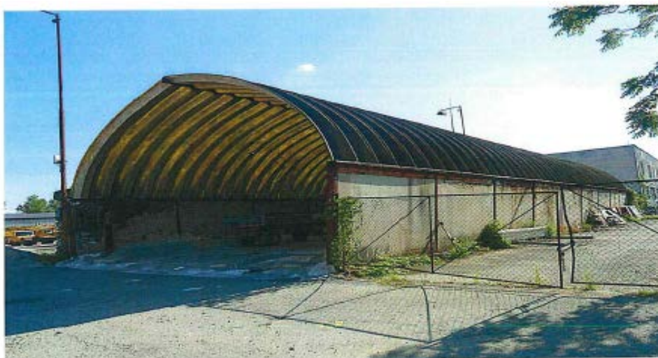
Obr.č.2 Pohľad zadný, celkový pohľad na sklad
