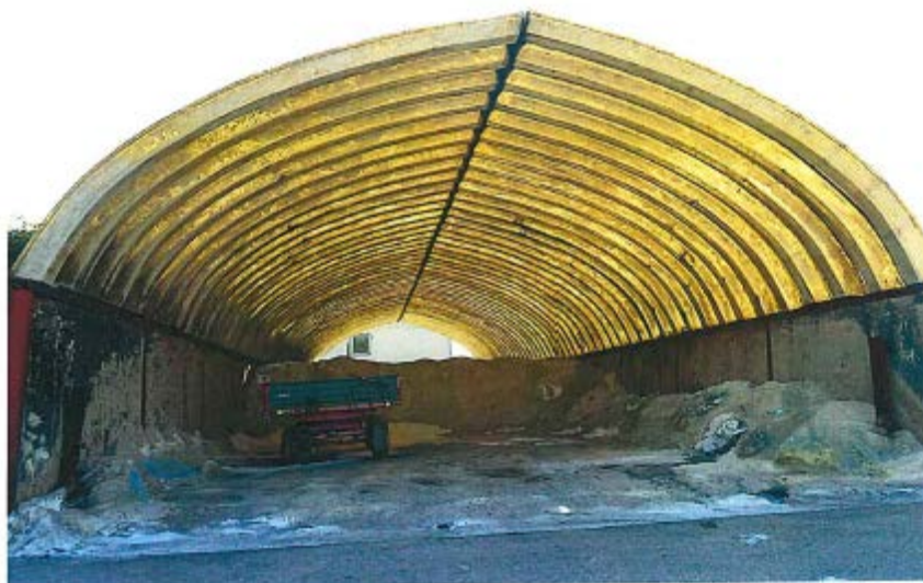
Obr. č.1 Pohľad na oblúkovú konštrukciu haly /Sklolaminátová krytina, železobetónové steny hr. 150 mm/
