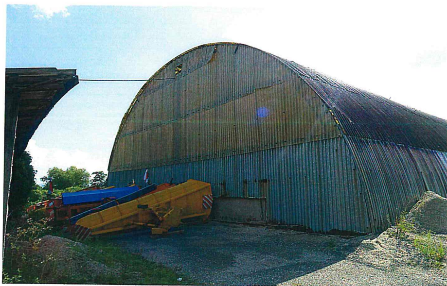
Obr. č.2 Pohľad čelný /sklolaminátová krytina, spodná časť steny – trapezový plech/
