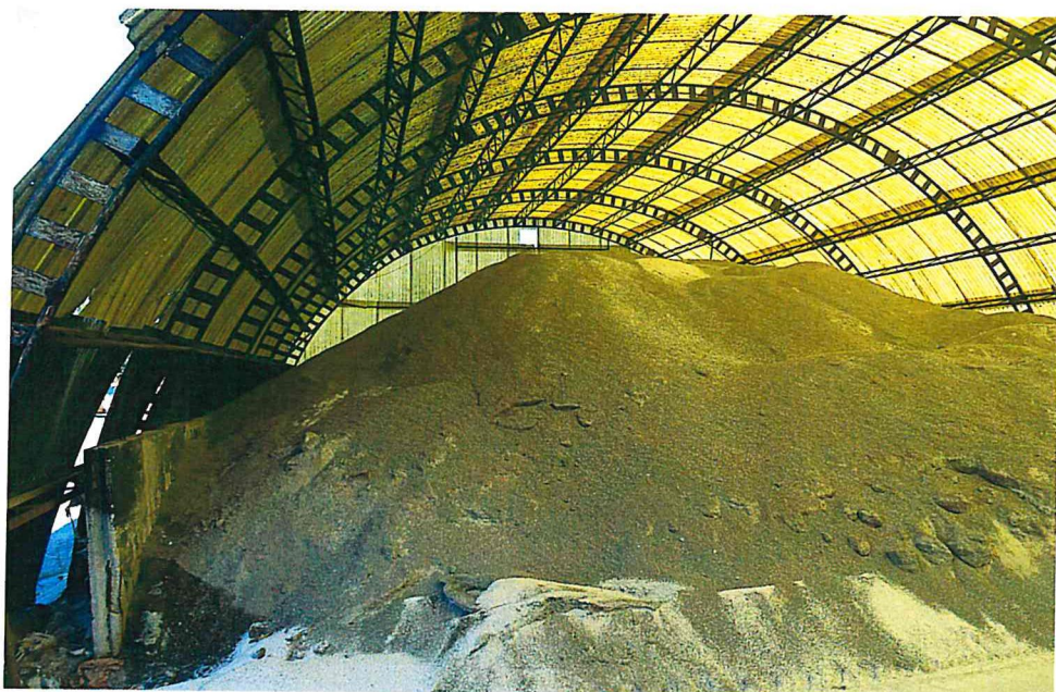
Obr. č.1 Pohľad na oblúkovú konštrukciu haly /Sklolaminátová krytina, trúbková konštrukcia/
