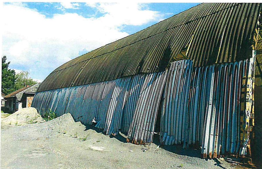
Obr.č.3 Pohľad zadný, pohľad na opláštenie skladu
