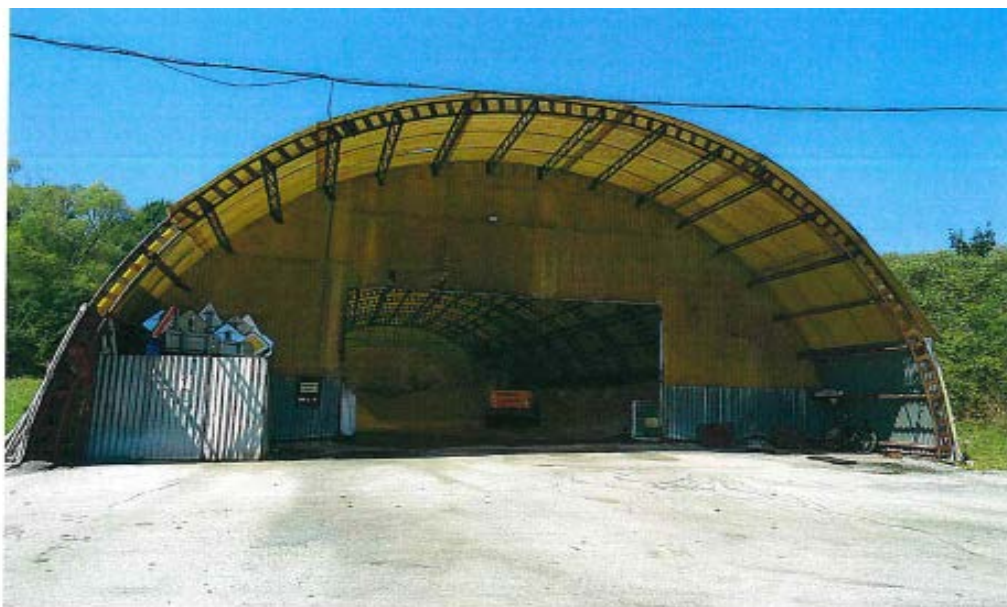
Obr. č.2 Pohľad čelný /sklolaminátová krytina, spodná časť steny – trápezový plech/
