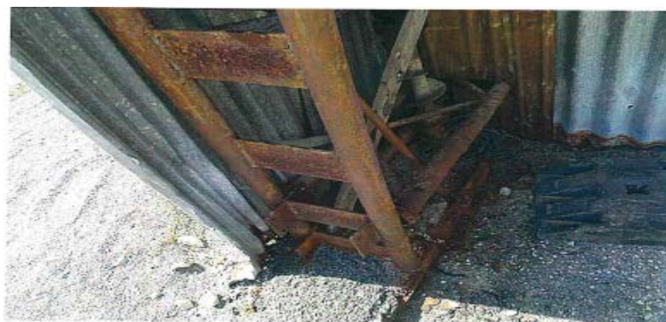
Obr.č.4 Detail nosnej konštrukcie skladu pri kotvení /korózia, deformácie/
