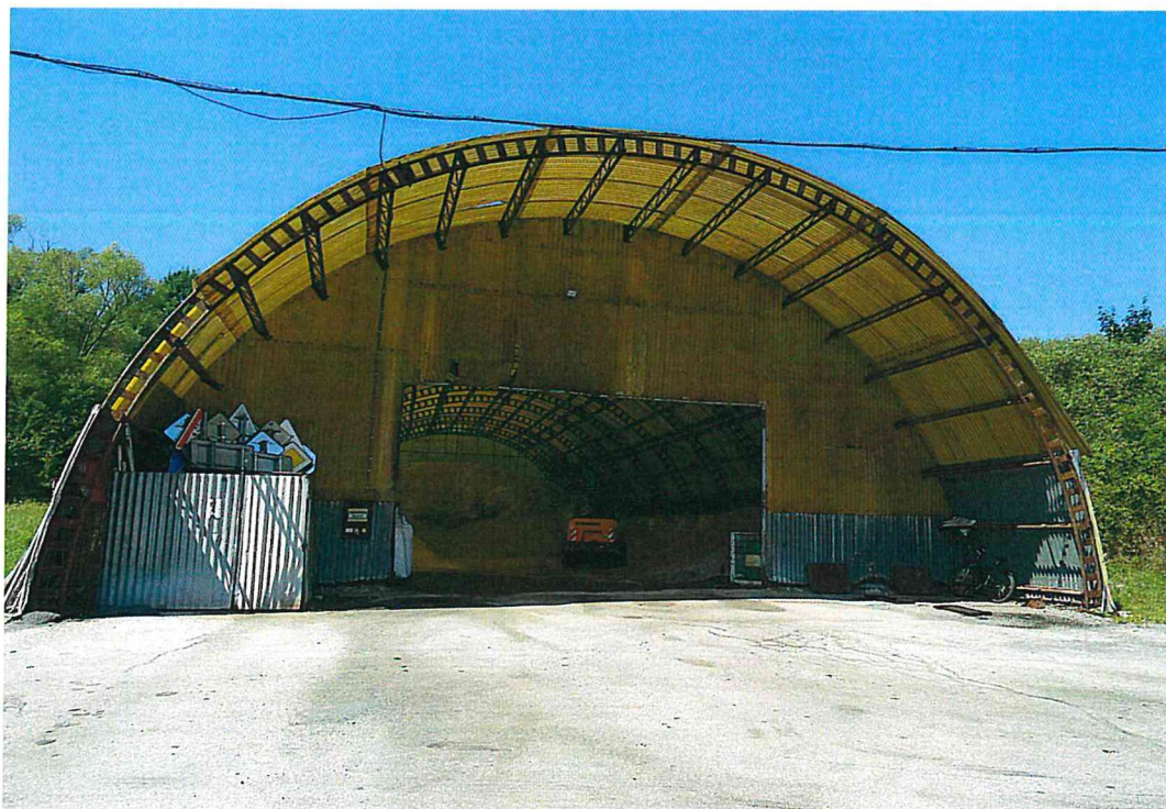
Obr. č.2 Pohľad čelný /sklolaminátová krytina, spodná časť steny – trápezový plech/
