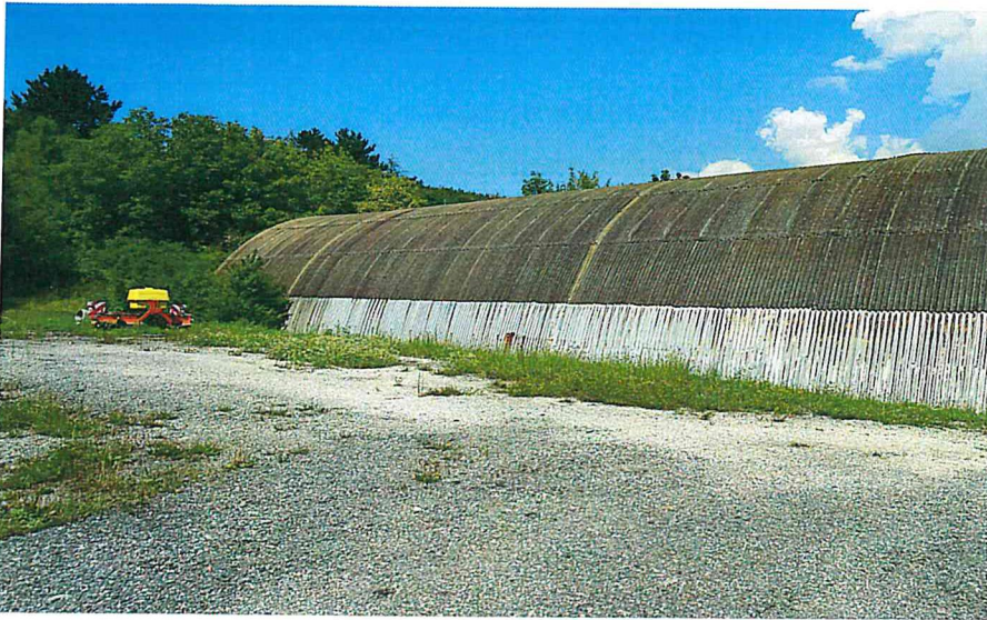
Obr.č.3 Pohľad bočný, pohľad na opláštenie skladu
