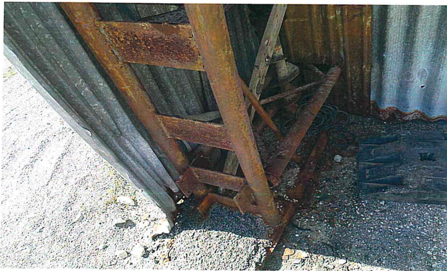
Obr.č.4 Detail nosnej konštrukcie skladu pri kotvení /korózia, deformácie/
