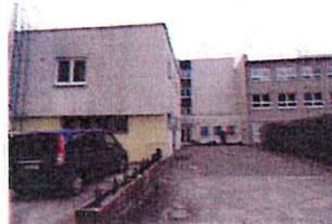
Objekt garáže a bytovaj jednotky
