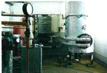
Kotolňa na zemný plyn v suteréne budovy (1. PP) prístupná z exteriéru
