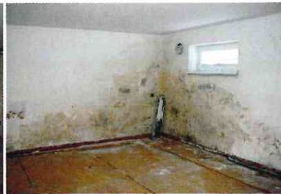
Poškodenie izolácie (1. PP)
