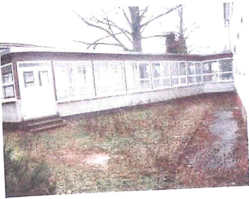
Spojovacia chodba na p.č.KN 418/17
