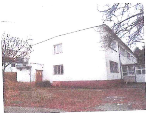
Budova SOU/B s.č. 1389
