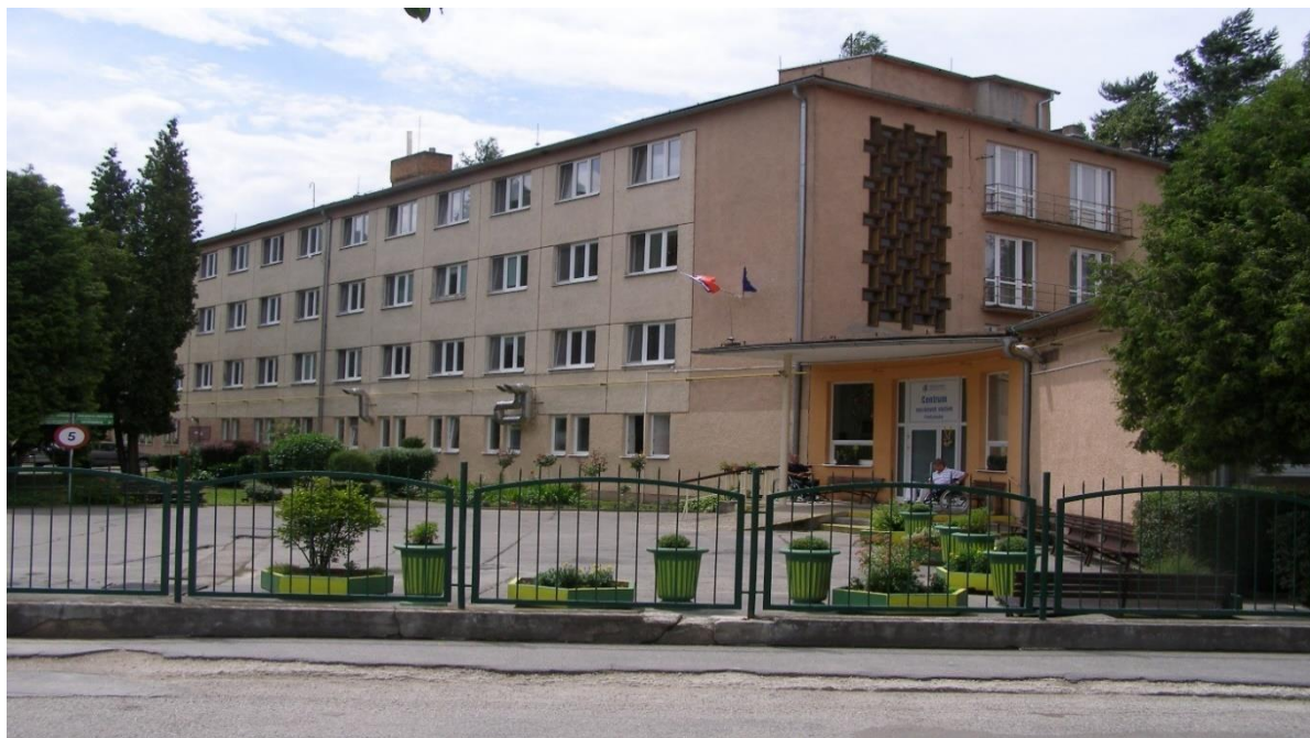
Budova Centra sociálnych služieb Partizánske
