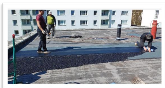
Oprava strechy DD2 a SOV
