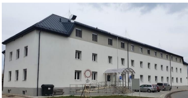
Budova CSS-AVE po rekonštrukcii v roku 2021
