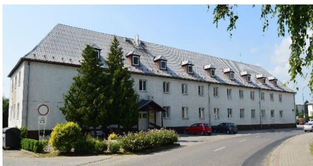
Budova CSS-AVE pred rekonštrukciou v roku 2019
