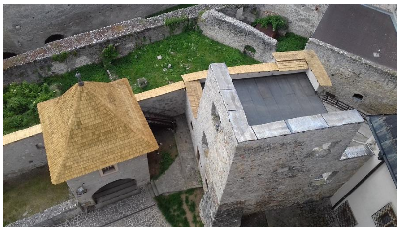
Obr. č. 4: Výmena šindľovej krytiny na 5. bráne a letnej veži stav po zásadu
