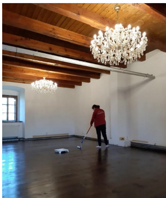
Obr. č. 7: Výmena podláh v Beckove
