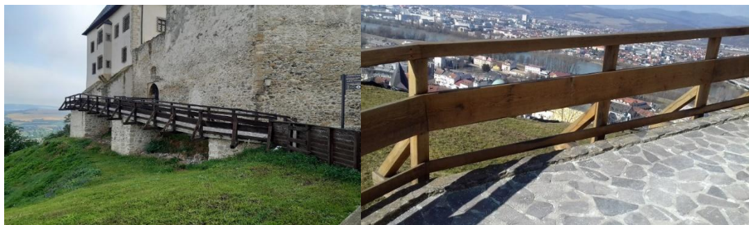
Obr. č. 1: Most pred štvrtou bránou stav pred a po výmene
