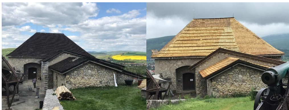
Obr. č. 5: Výmena šindľovej krytiny na Delovej bašte stav pred a po zásadu
