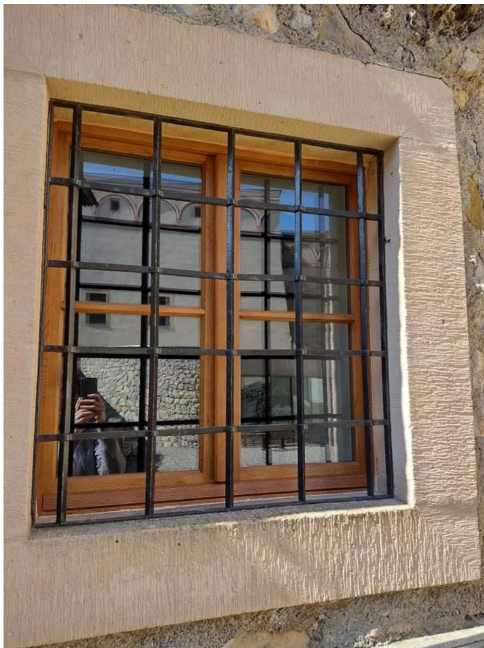
Obr. č. 18: Vymenené okno na Trenčianskom hrade
