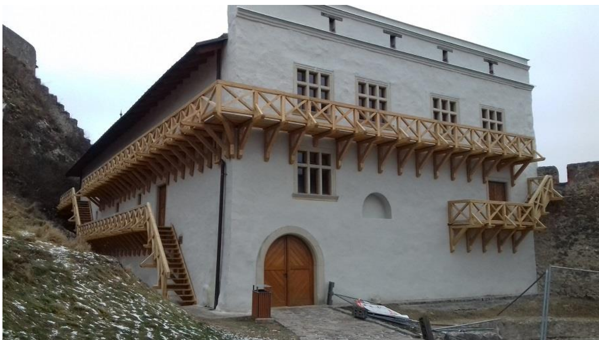
Obr. č. 8: Oprava ochodze hradnej kasárne – po zásahu
