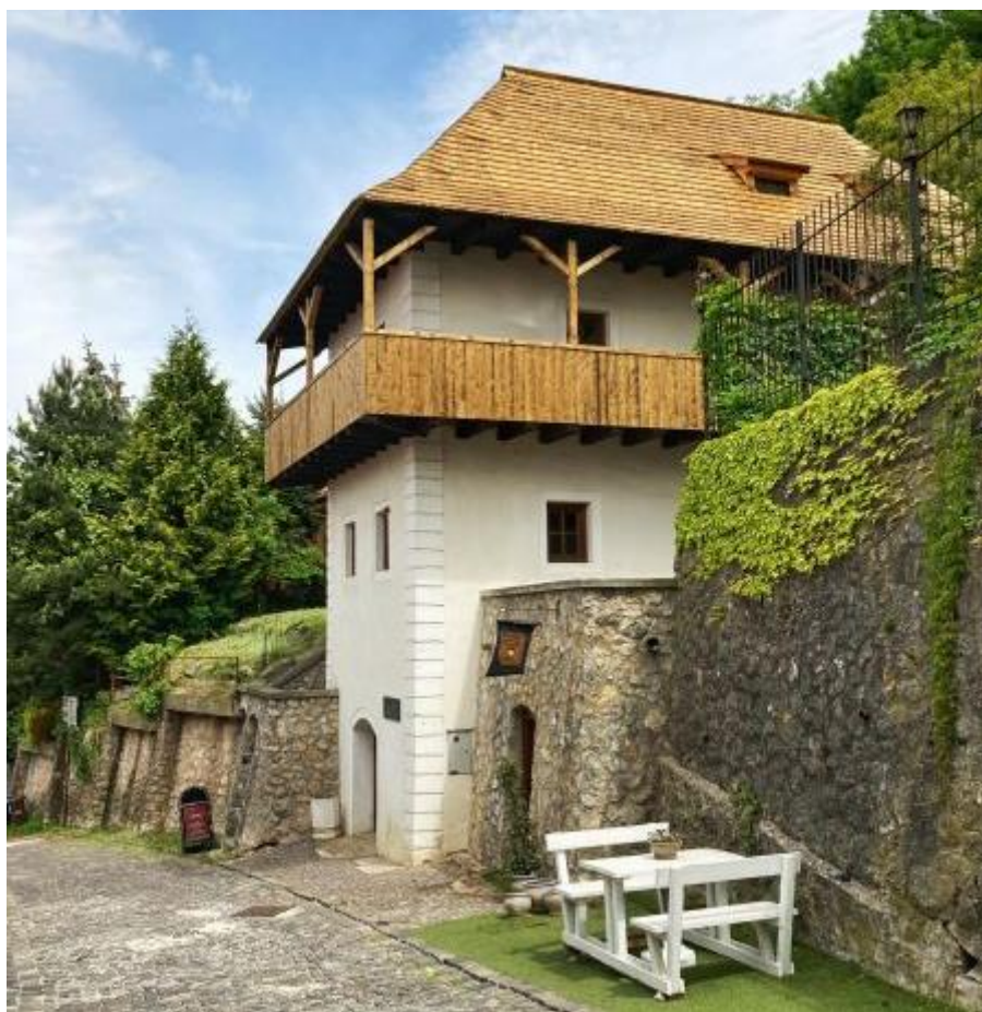
Obr. č. 2: Strešná krytina – Katov dom – po zásahu
