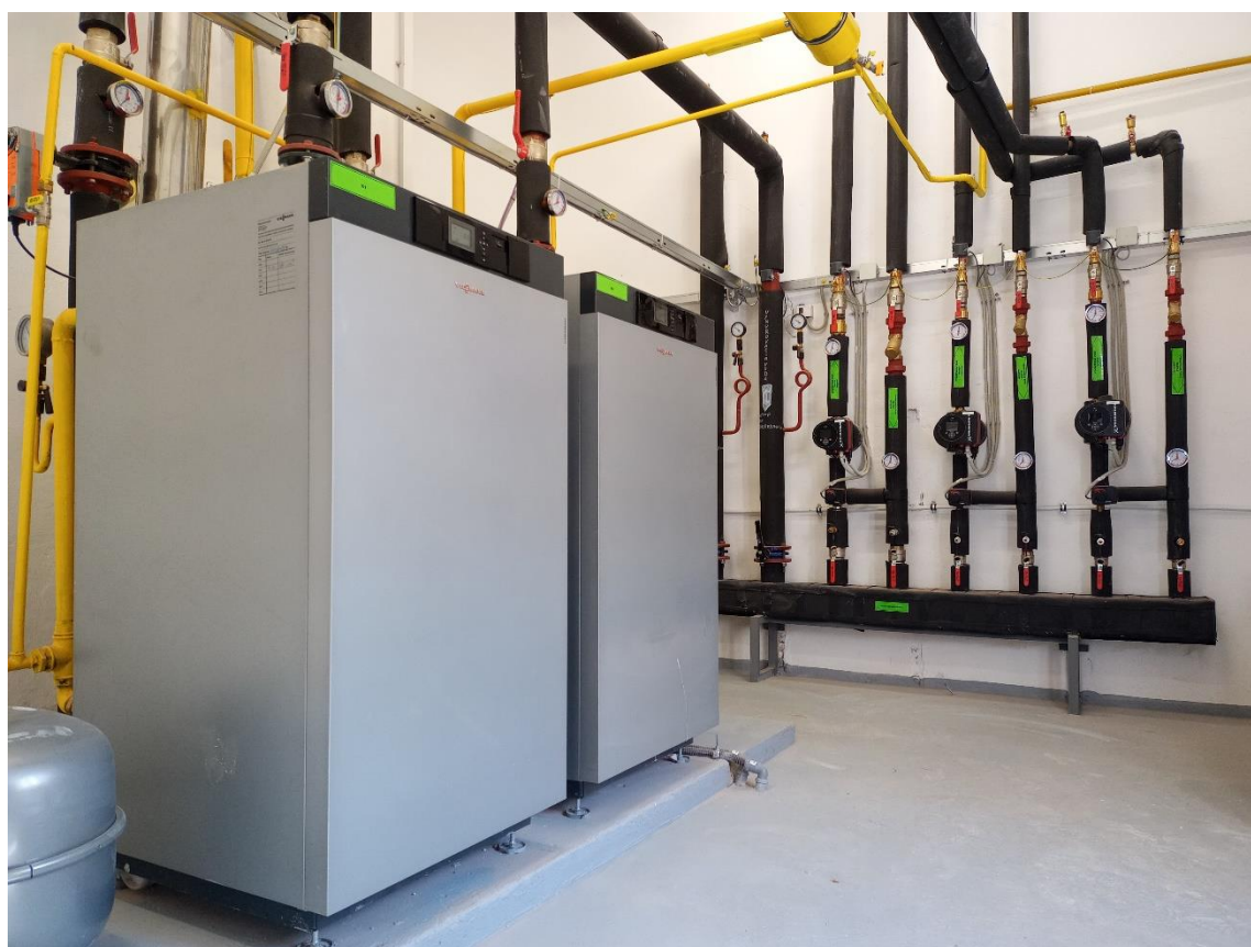
Obr. č. 14: Rekonštrukcia kotolne a rozvodov v Podjavorinskom múzeu – po zásahu
