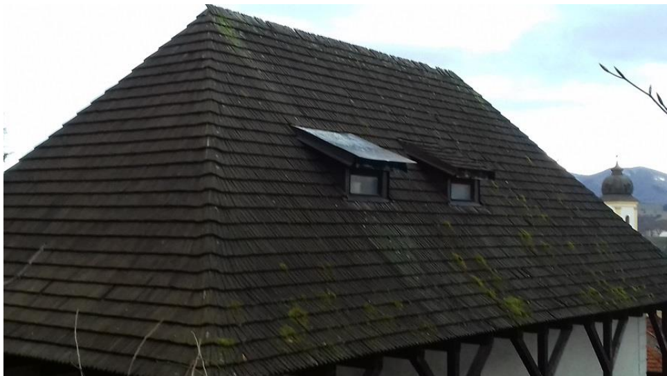
Obr. č. 1: Strešná krytina – Katov dom – pred zásahom
