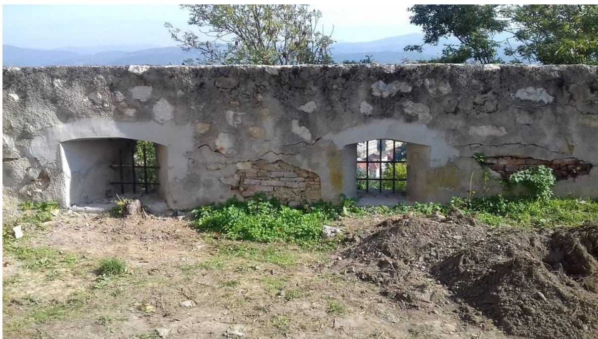
Obr. č. 10: Oprava záklenkov Južného opevnenia – po zásahu
