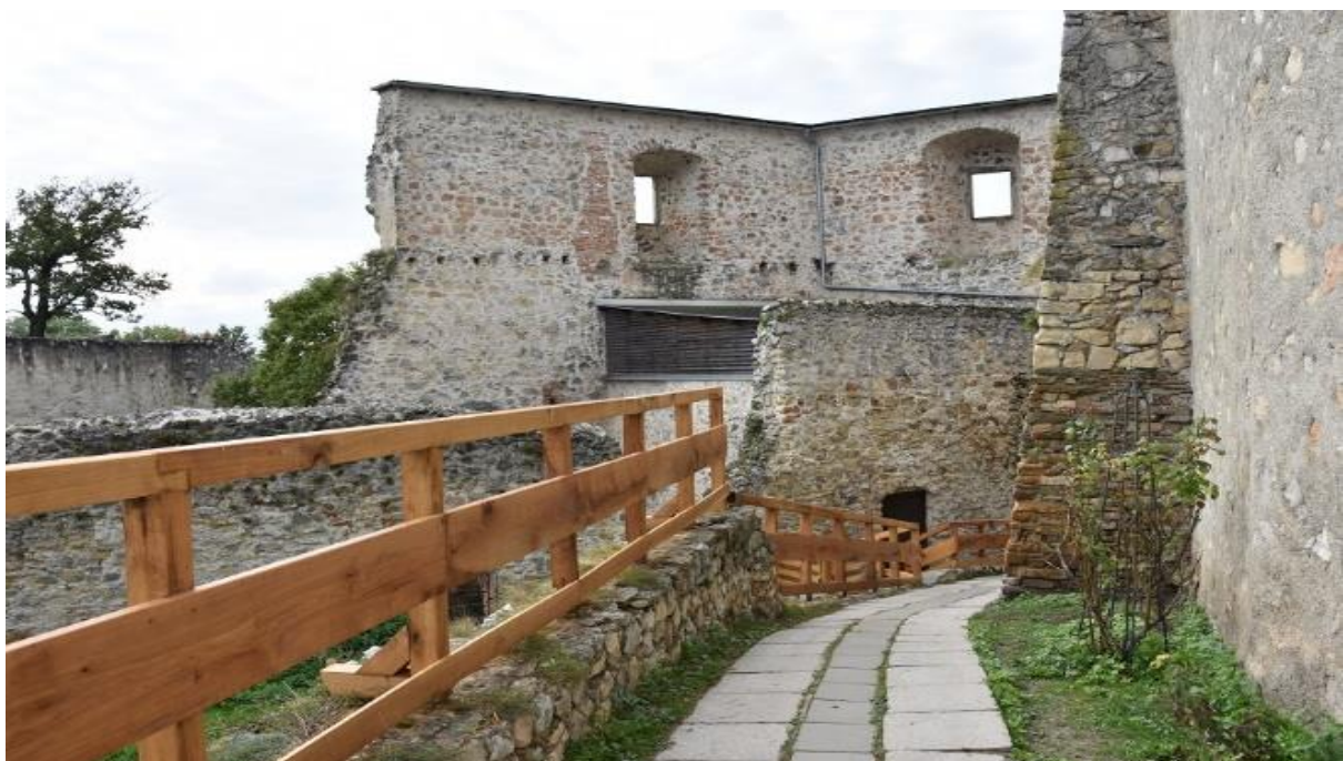
Obr. č. 12: Oprava dreveného zábradlia medzi IV. a V. bránou – po zásahu
