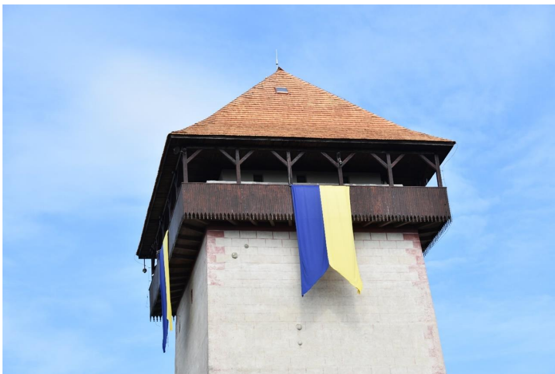
Obr. č. 6: Oprava zastrešenia Matúšovej veže – po zásahu
