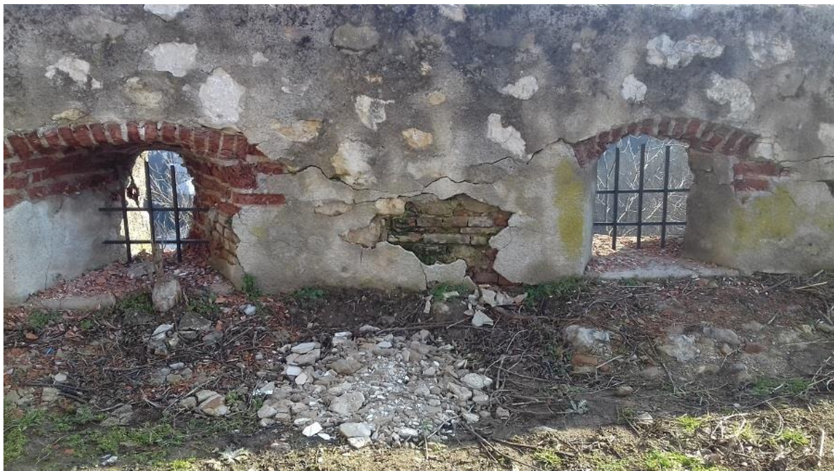
Obr. č. 9: Oprava záklenkov Južného opevnenia – pred zásahom
