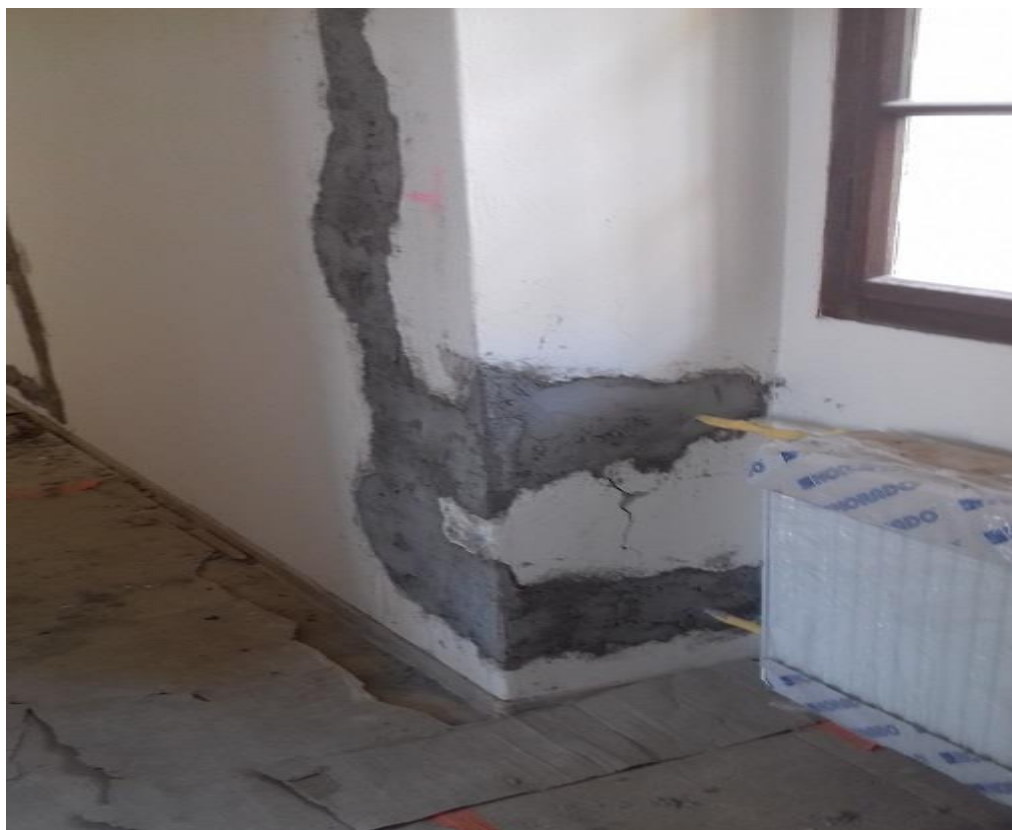
Obr. č. 13: Rekonštrukcia kotolne a rozvodov v Podjavorinskom múzeu – priebeh prác
