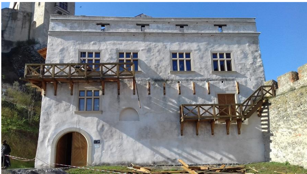
Obr. č. 7: Oprava ochodze hradnej kasárne – pred zásahom
