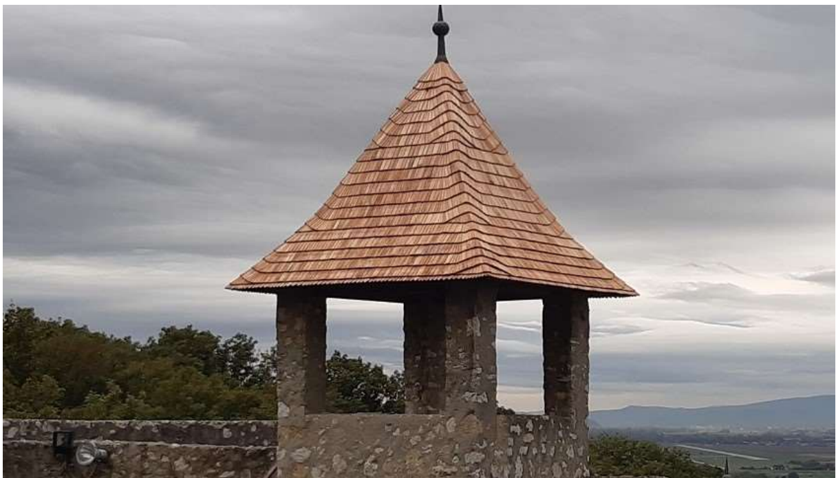
Obr. 15: Výmena strešnej krytiny na NKP Trenčiansky hrad - Vežička 1345/28,23 – nový stav
