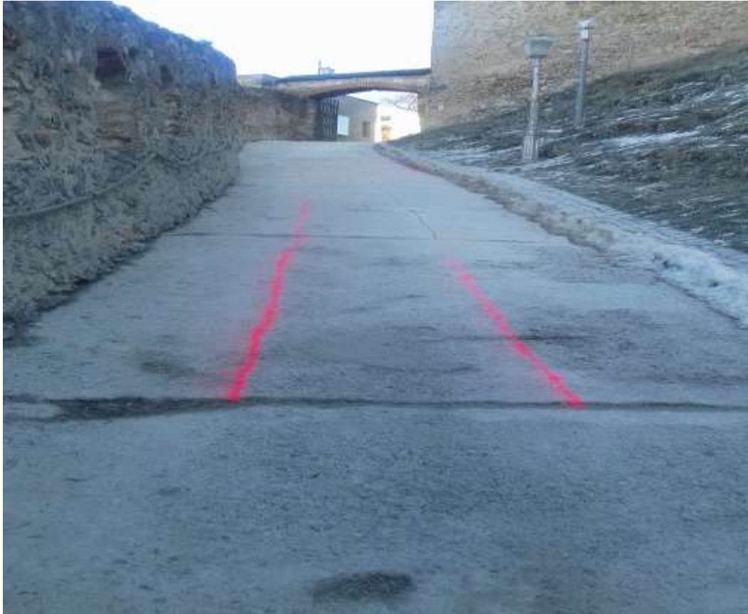
Obr. 3: Rekonštrukcia prístupovej komunikácie medzi prvou a druhou bránou Trenčianskeho hradu - pôvodný stav
