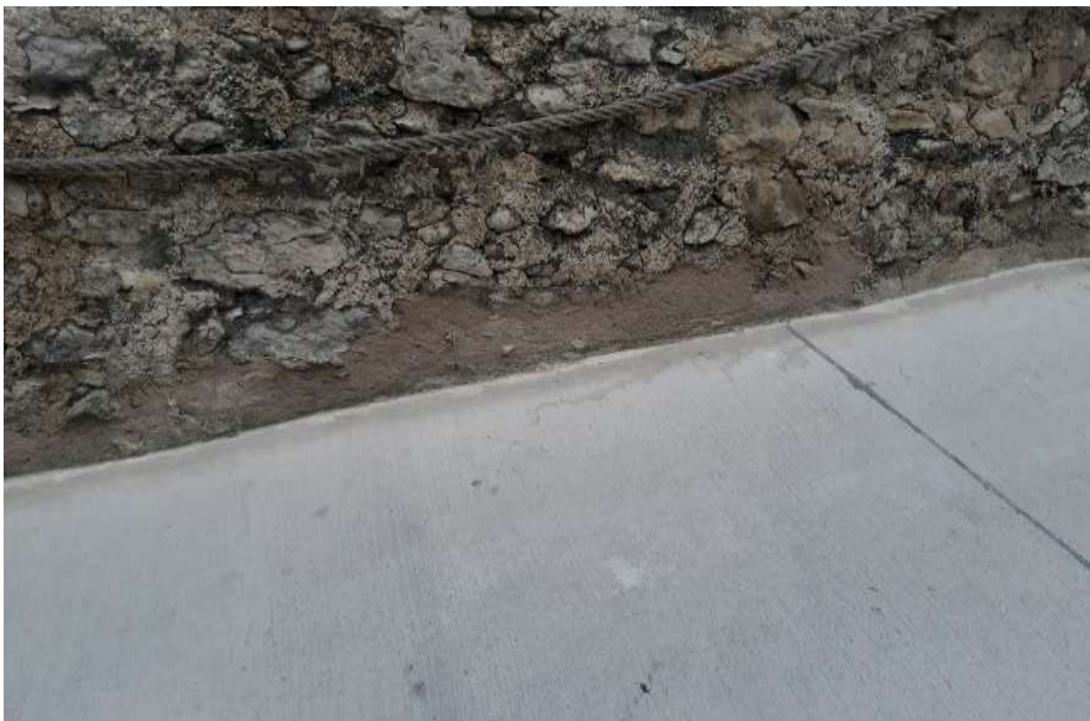
Obr. 13: Oprava päty múru medzi prvou a druhou bránou Trenčiansky hrad – stav po oprave
