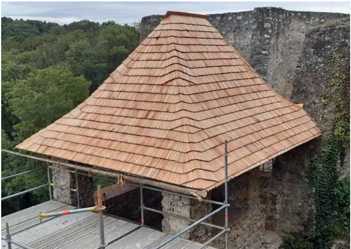
Obr. 17: Výmena strešnej krytiny na NKP Trenčiansky hrad - Veža bránová II – nový stav
