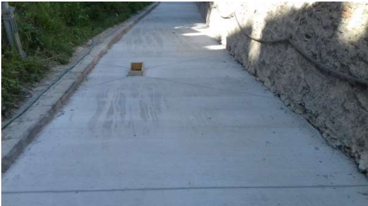
Obr. 4: Rekonštrukcia prístupovej komunikácie medzi prvou a druhou bránou Trenčianskeho hradu - po rekonštrukcii
