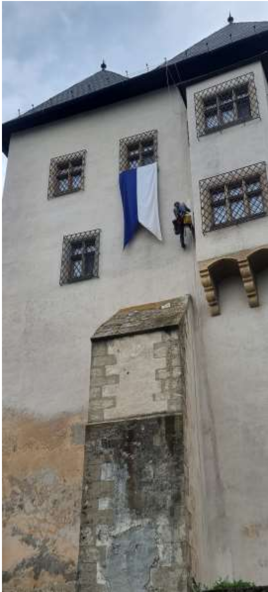
Obr. 9: Rekonštrukcia bleskozvodnej sústavy objektov horného hradu - priebeh prác
