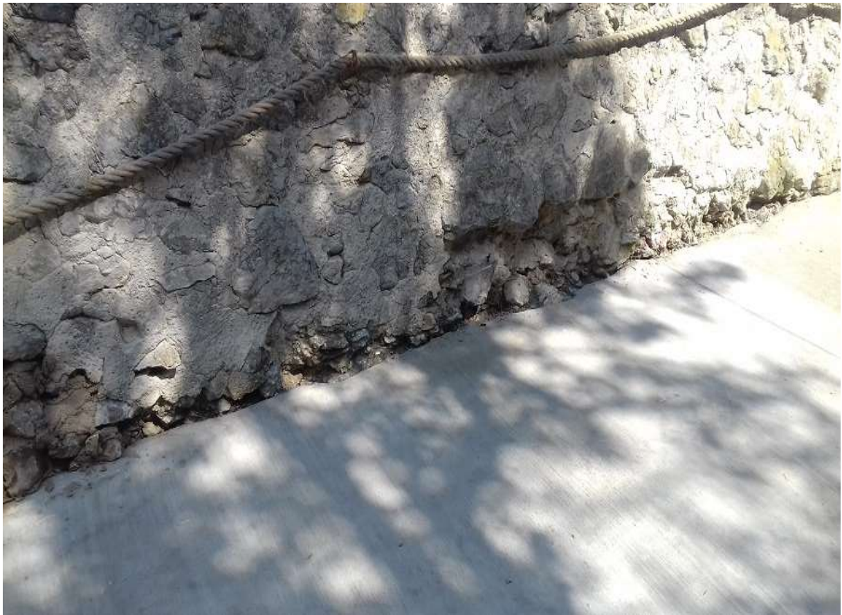
Obr. 12: Oprava päty múru medzi prvou a druhou bránou Trenčiansky hrad – pôvodný stav
