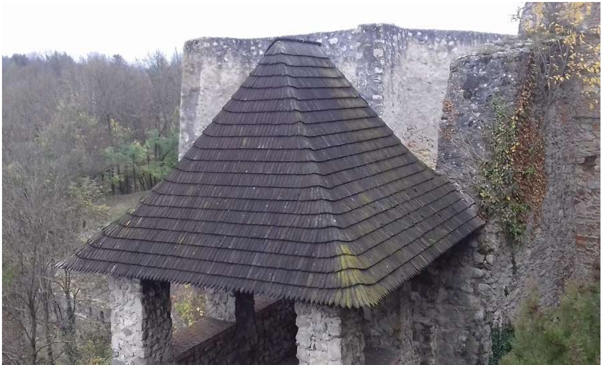
Obr. 16: Výmena strešnej krytiny na NKP Trenčiansky hrad - Veža bránová II – pôvodný stav
