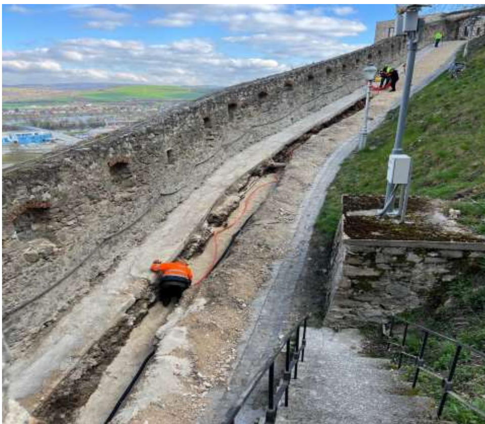
Obr. 2: Výmena vodovodnej prípojky na Trenčiansky hrad – II. etapa, priebeh realizácie
