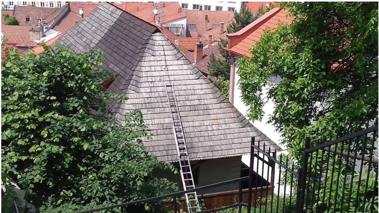
Obr. 5: Náter striech na objektoch Katov dom a Uhrovec - pôvodný stav Katov dom
