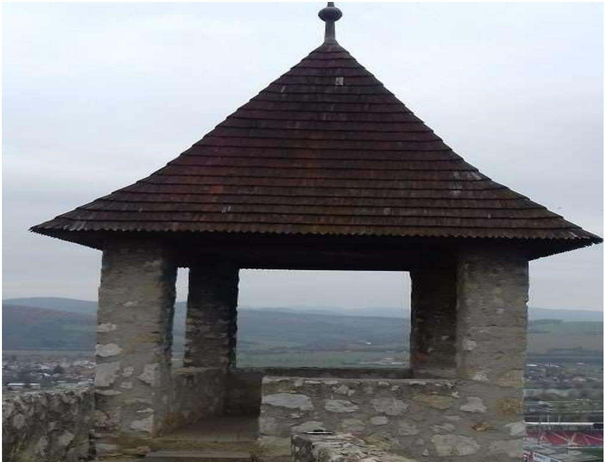
Obr. 14: Výmena strešnej krytiny na NKP Trenčiansky hrad - Vežička 1345/28,23 – pôvodný stav
