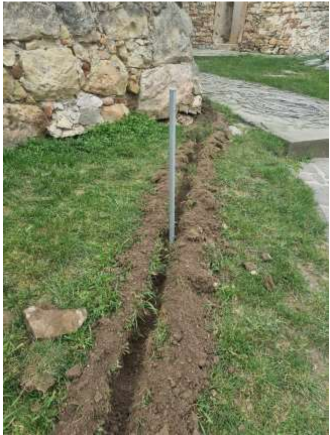
Obr. 10: Rekonštrukcia bleskozvodnej sústavy objektov horného hradu - priebeh prác
