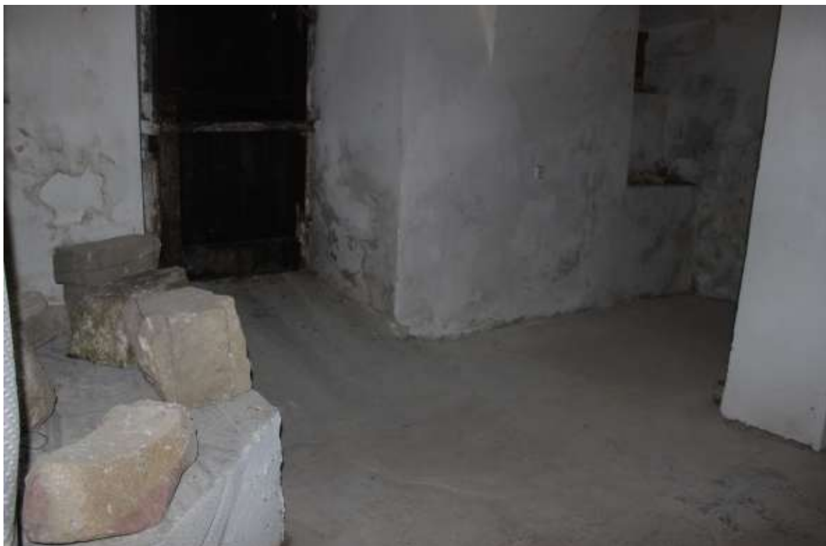
Obr. 4: Revitalizácia Draškovičovho kaštieľa v Čachticiach, pivničné priestory pre expozíciu - pôvodný stav
