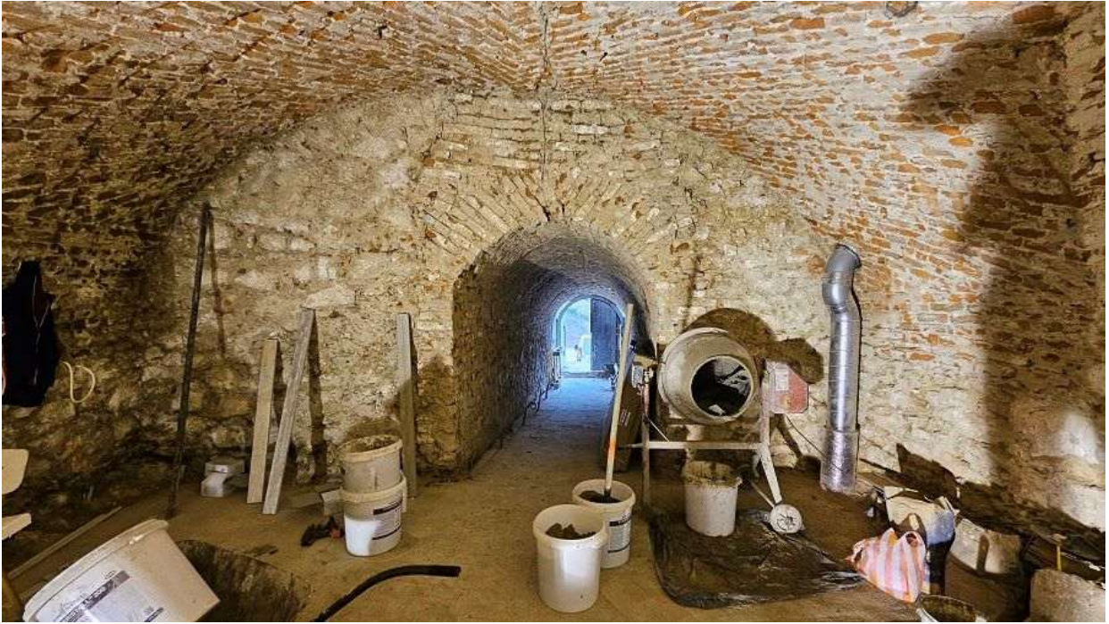
Obr. 7: Revitalizácia Draškovičovho kaštieľa v Čachticiach, pivničné priestory - pôvodný stav
