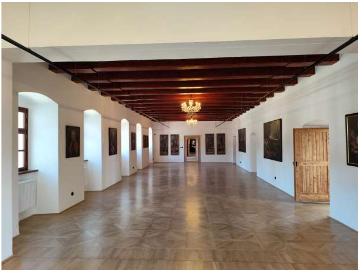
Obr. 2: Revitalizácia Draškovičovho kaštieľa v Čachticiach, obrazová galéria na II. nadzemnom podlaží - po rekonštrukcii
