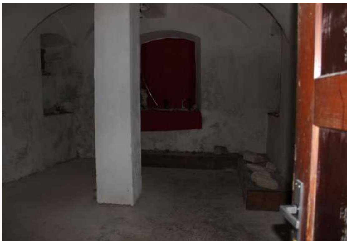
Obr. 3: Revitalizácia Draškovičovho kaštieľa v Čachticiach, pivničné priestory pre expozíciu - pôvodný stav
