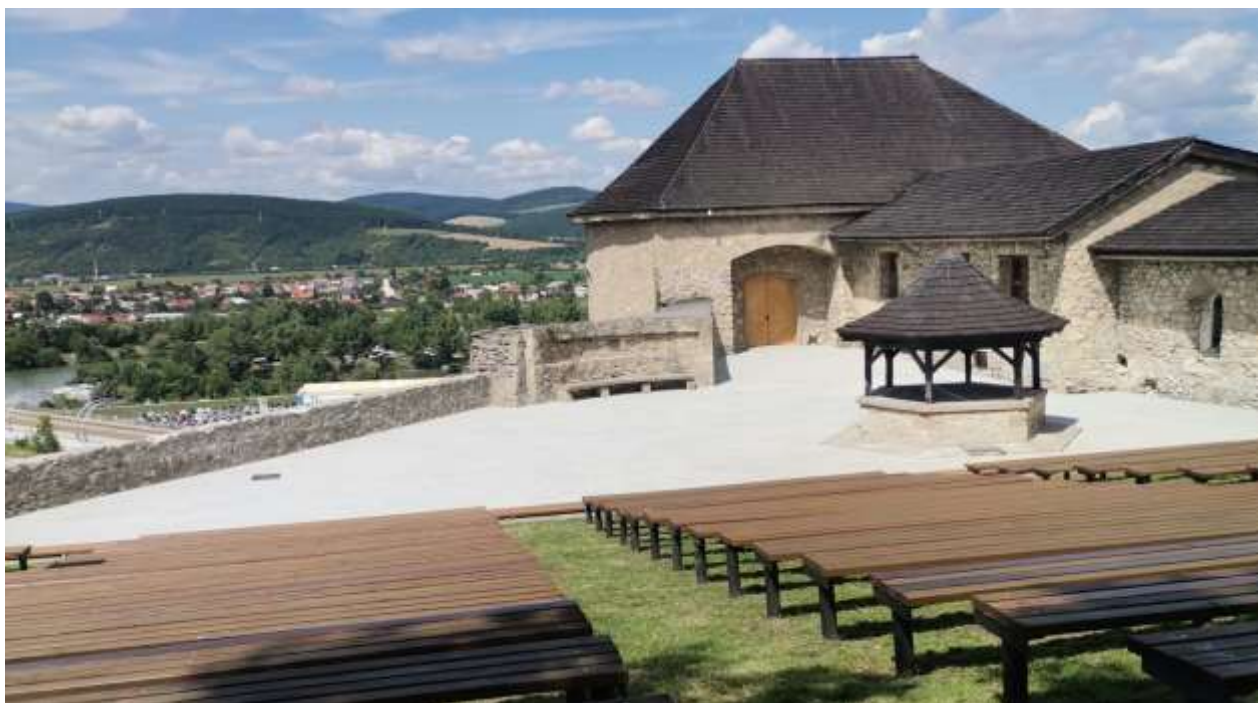
Obr. 6: Obnova spevnených plôch v areáli Trenčianskeho hradu, po rekonštrukcii
