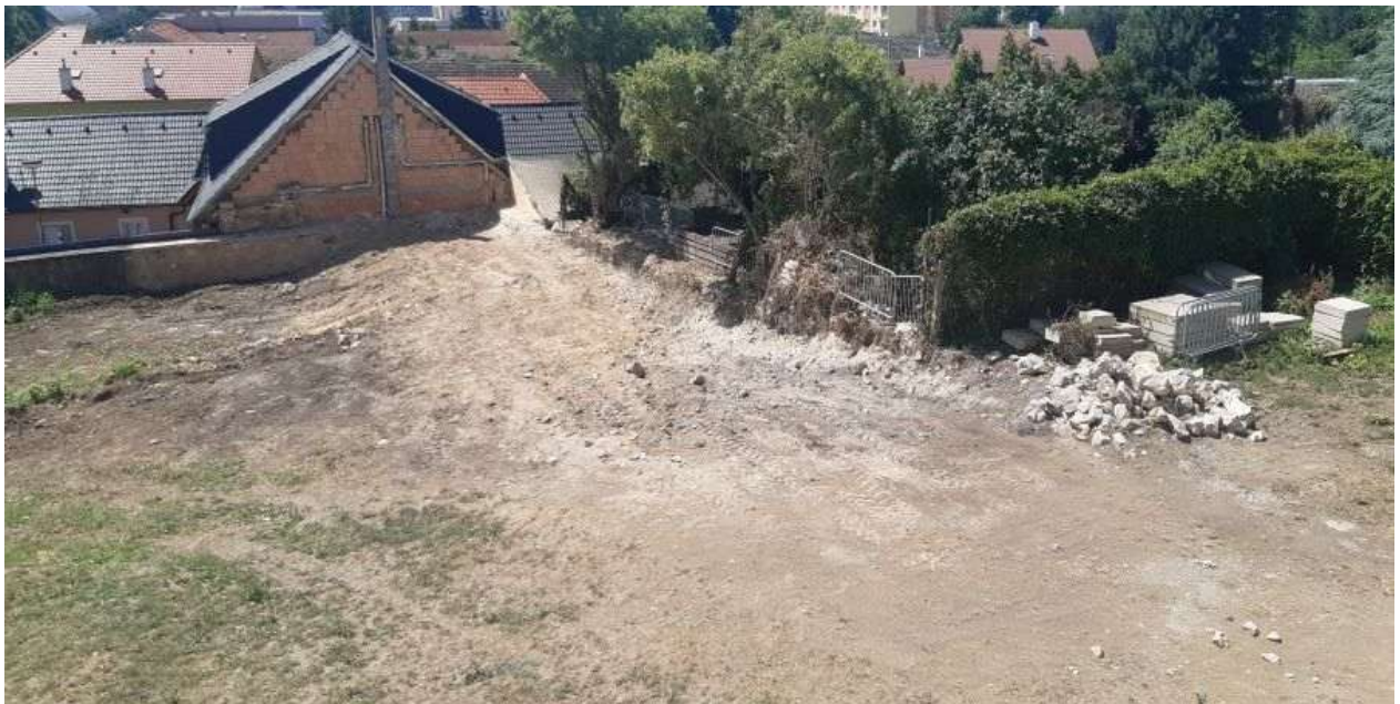
Obr. 8: Odstránenie stavby – areál Draškovičovho kaštieľa Čachtice, po sanácií
