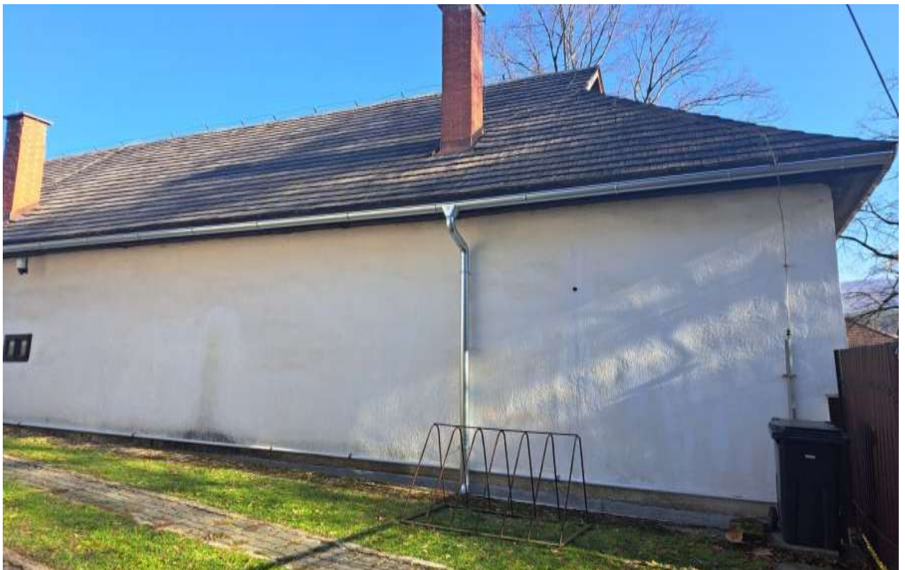
Obr. 2: Montáž strešných zvodov a žlabov - Rodný dom Ľudovíta Štúra a Alexandra Dubčeka v Uhrovci, po výmene
