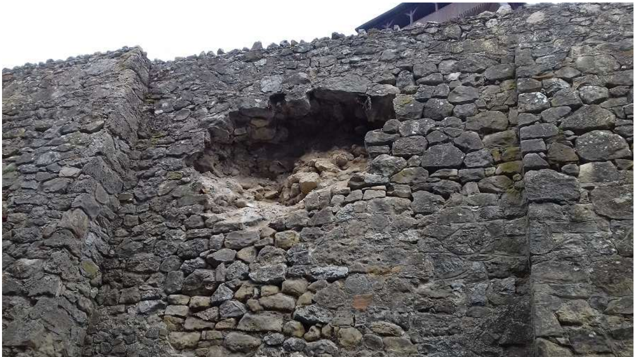
Obr. 3: Obnova vybraných objektov v juhovýchodnej časti hradného jadra na NKP Trenčiansky hrad, 1. etapa, pôvodný stav
