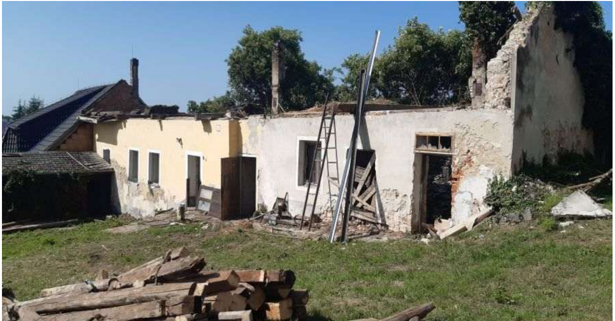
Obr. 7: Odstránenie stavby – areál Draškovičovho kaštieľa Čachtice, pôvodný stav
