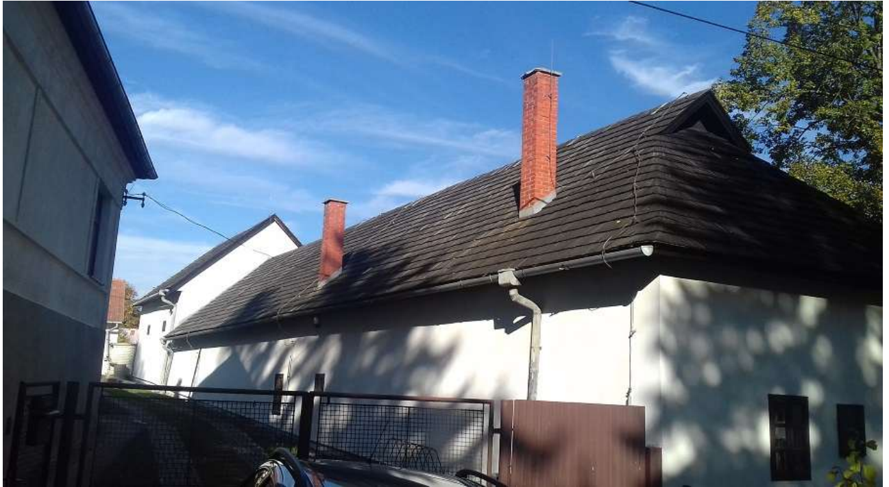
Obr. 1: Montáž strešných zvodov a žlabov - Rodný dom Ľudovíta Štúra a Alexandra Dubčeka v Uhrovci, pôvodný stav
