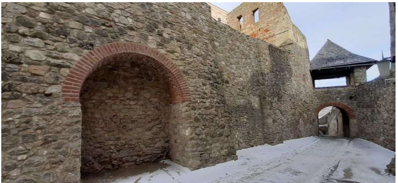
Obr. 4: Obnova vybraných objektov v juhovýchodnej časti hradného jadra na NKP Trenčiansky hrad, 1. etapa, po rekonštrukcii
