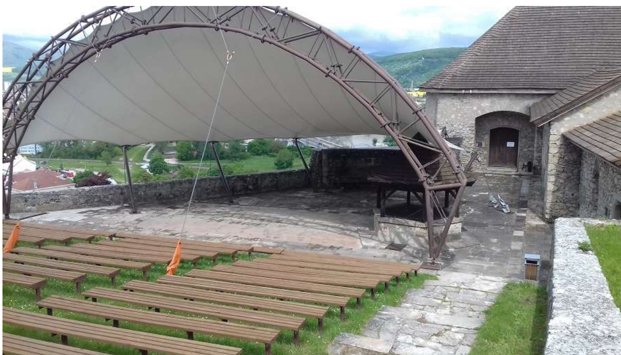
Obr. 5: Obnova spevnených plôch v areáli Trenčianskeho hradu, pôvodný stav
